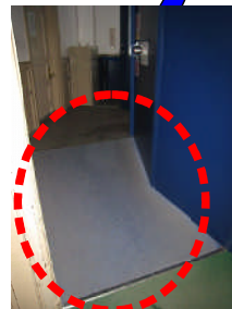
タイフーンボックスの入口はスロープがあります。スロープ幅は約1.2mです。
