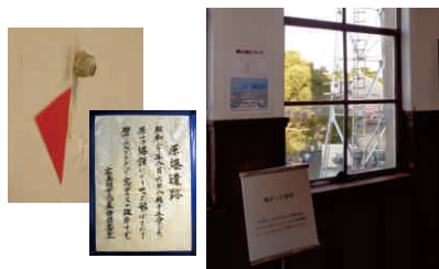
壁に刺さったガラス片と曲がった窓枠
